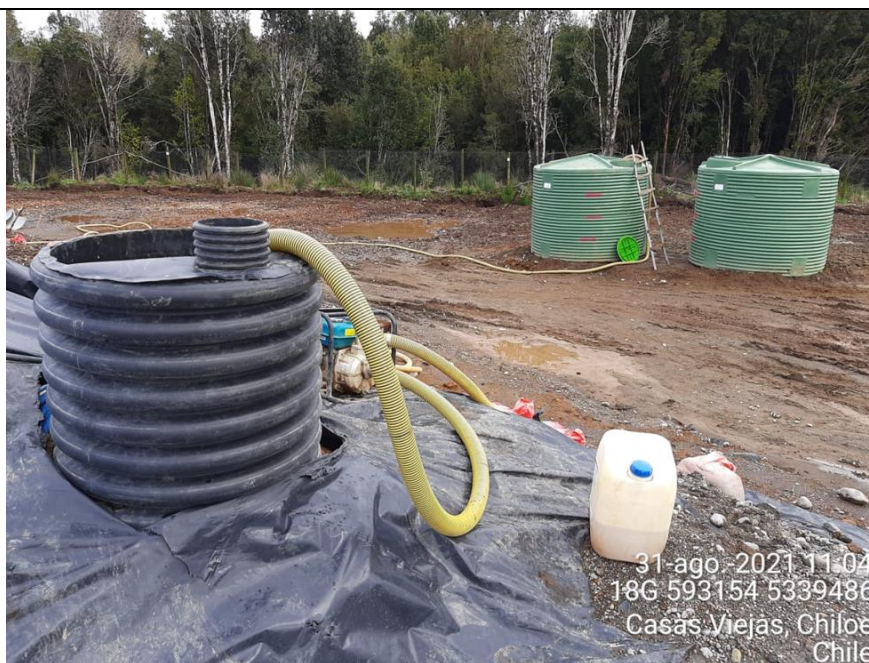
Fotografía N°3: Retiro de Lixiviados de cámaras de inspección de sobrecelda C10 por Personal Municipal. Tomada: Martes 31 de Agosto del 2021.
