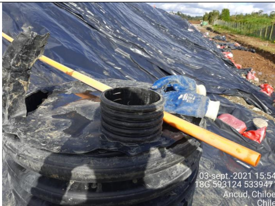
Fotografía N°14: Medición de Niveles de cámaras de inspección por Personal Municipal.
