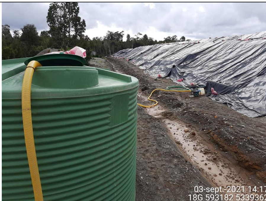
Fotografía N°9: Retiro de Lixiviados desde D2 a estanques por Personal Municipal. Tomada: Viernes 03 de Septiembre del 2021.
