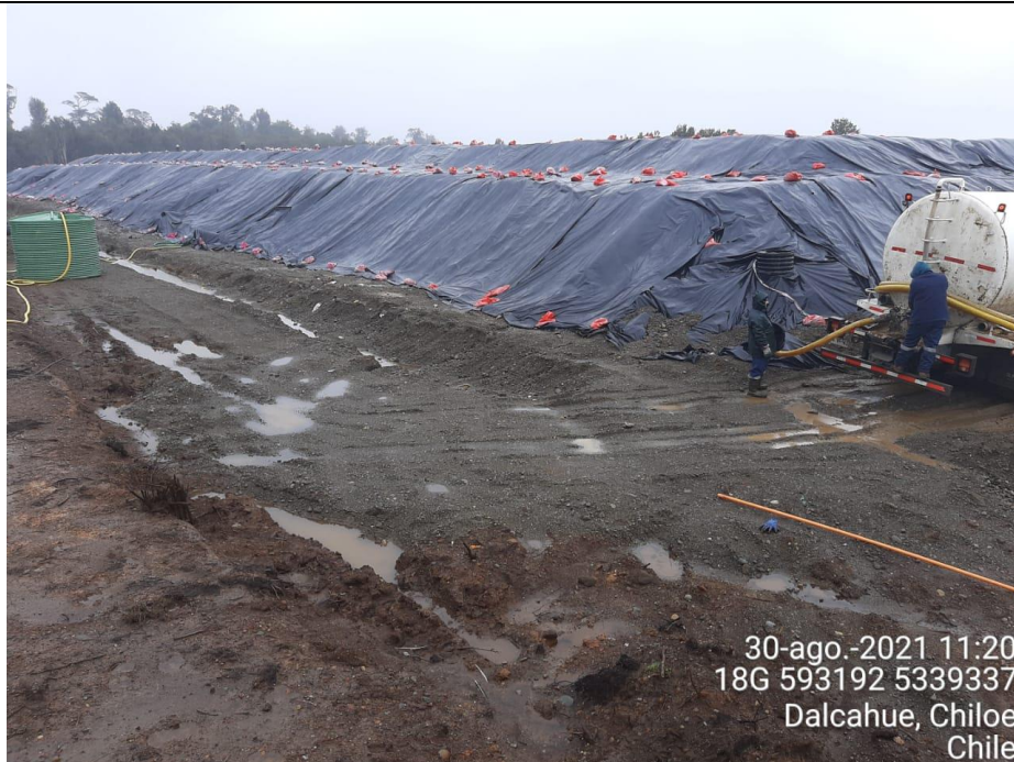
Fotografía N°2: Retiro de Lixiviados de ductos diagonales D2 y D3 y estanque acumulación zona de adecuación. Tomada: Lunes 30 de Agosto del 2021.
