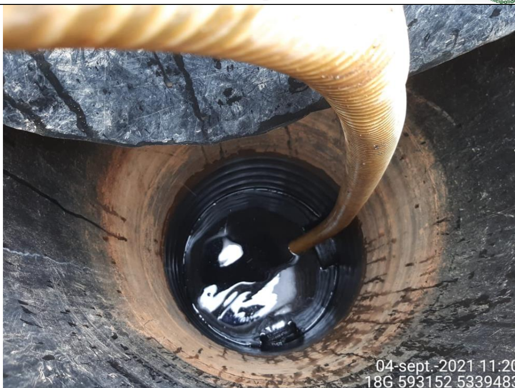
Fotografía N°11: Retiro de Lixiviados a Estanques de acumulación C10 por Personal Municipal.
